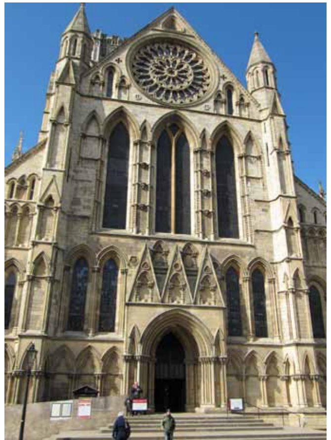
Inngang mot sør med rosevindu.
